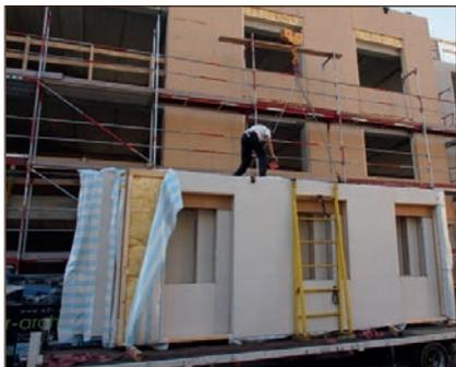
Tagen. Die hochgedämmten Wände in Holzrahmenbauweise wurden im Werk vorgefertigt und mittels 40 m Turmdrehkran an ihren Bestimmungsort bewegt.
