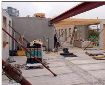
werden bereits während der Montage auf jeder Etage verteilt. Noch während auf dem 2. OG die letzten Außenbauteile montiert werden entstehen bereits die ersten Innenwände!
